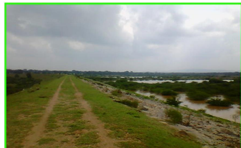
Pic 5.1.3. (d) Upstream of Dam (Water Storage)
