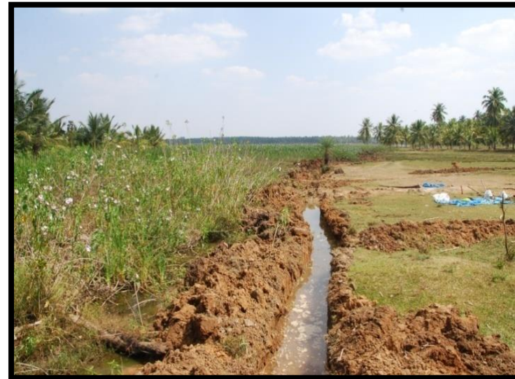
Pic 5.10. (d) Formation of Surface Drain Work
